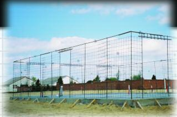
Antes de montar las formaletas se realiza un reforzamiento estructural
